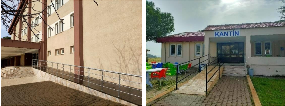
Resim 1. Yapı girişlerinde yer alan rampalar.
